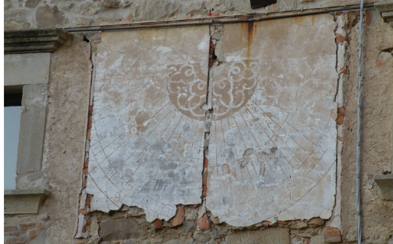
Particolare dell'orologio solare di casa Parisi prima del restauro.
